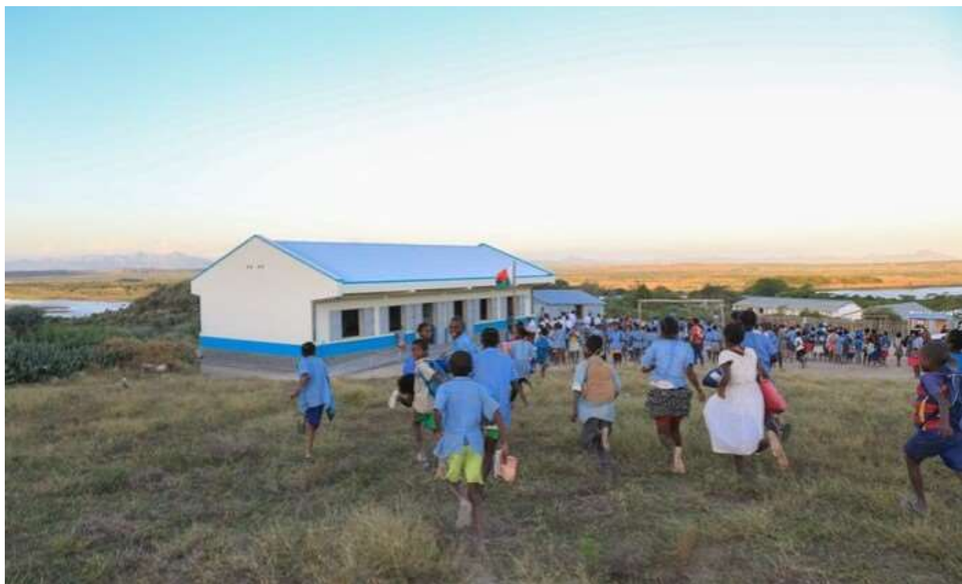
L'appui de l'UNICEF dans le sud a pu bénéficier à plus de 840 000 élèves dans le préscolaire, primaire et le secondaire dont 54% sont des filles. (c) UNICEF
