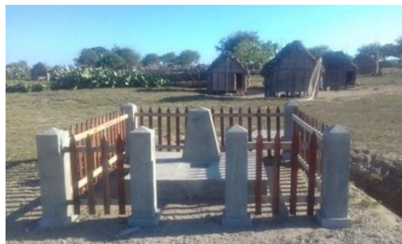
Construction d'un point d'eau à Nikoly, district de Tsihombe - UNICEF
