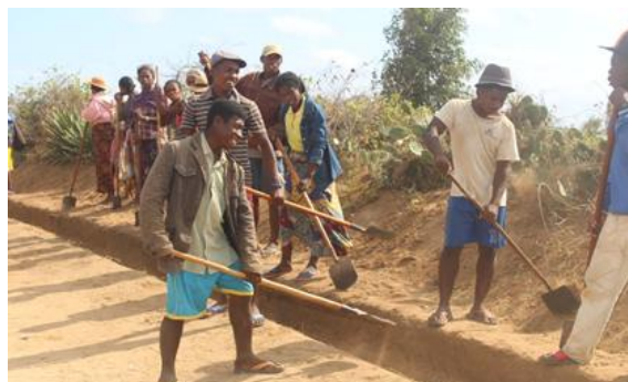
Réhabilitation d'une piste rurale à Ambovombe - PNUD
