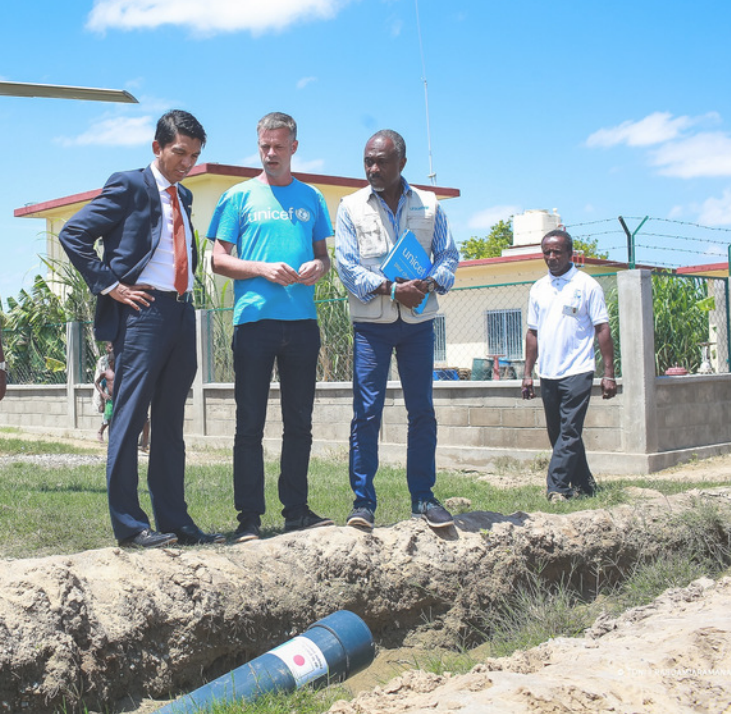
Visite des travaux du pipeline à Beloha par le Président de la République, en janvier 2019 (c) UNICEF
